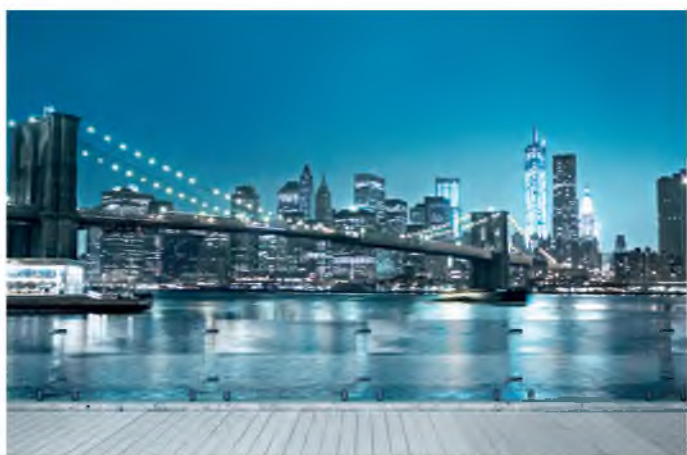
Инновационное оборудование KSB обеспечивает водоснабжение Нью-Йорка.
