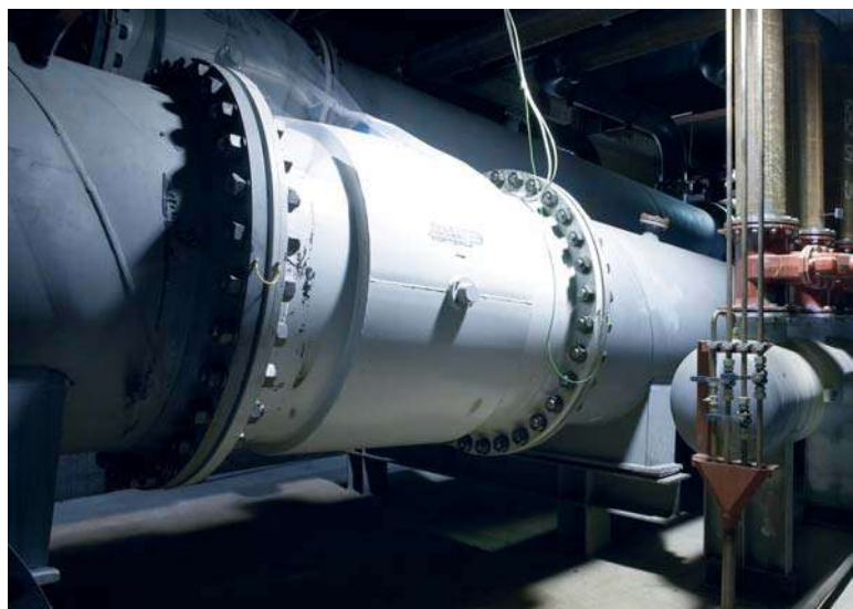
Стенд для испытаний насосов охлаждающей воды
